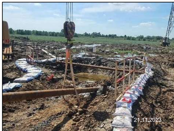
รูปที่ 2-15 การวางถุงทรายหรือจัดทำคันดินกันรอบพื้นที่บ่อรับ- บ่อส่ง
