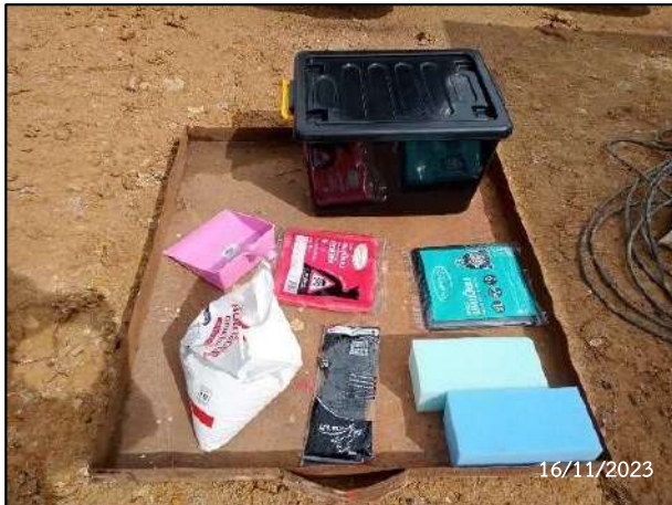
รูปที่ 2-23 จัดเตรียมภาชนะรองรับป้องกันการหกรั่วไหลของน้ำมันและสารเคมี พร้อมทั้งวัสดุดูดซับ
