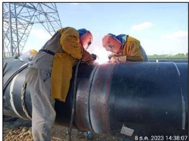
ข) การสวมใส่อุปกรณ์ป้องกันอันตรายของผู้ปฏิบัติงานเชื่อมท่อ
