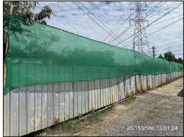
รูปที่ 2-5 ติดตั้งแผงพลาสติก/ผ้าใบเพิ่มเติม เพื่อป้องกันการฟุ้งกระจายของฝุ่นละอองในบริเวณพื้นที่ก่อสร้าง
