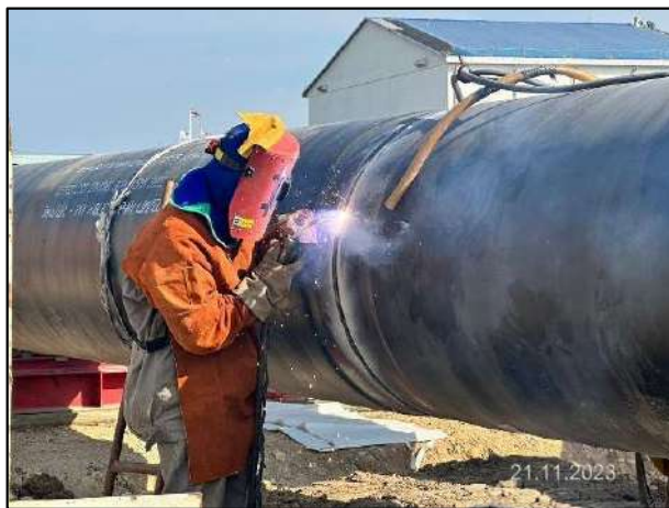
ข) การสวมใส่อุปกรณ์ป้องกันอันตรายของผู้ปฏิบัติงานเชื่อมท่อ
