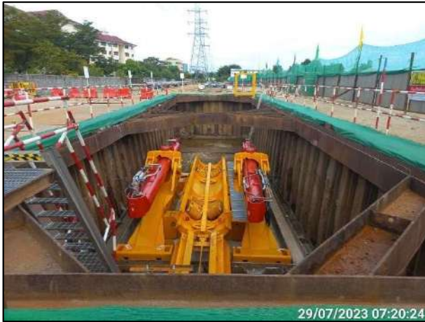
รูปที่ 2-14 การติดตั้ง Sheet pile ป้องกันการพังทลายของดินบริเวณบ่อรับ-บ่อส่ง
