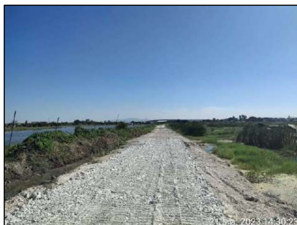
รูปที่ 2-16 การจัดทำทางชั่วคราว (Temporary Access Road)
