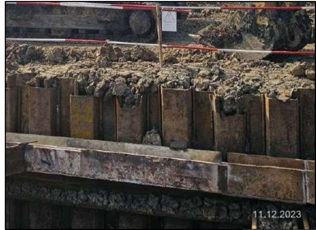
รูปที่ 2-14 การติดตั้ง Sheet pile ป้องกันการพังทลายของดินบริเวณบ่อรับ-บ่อส่ง
