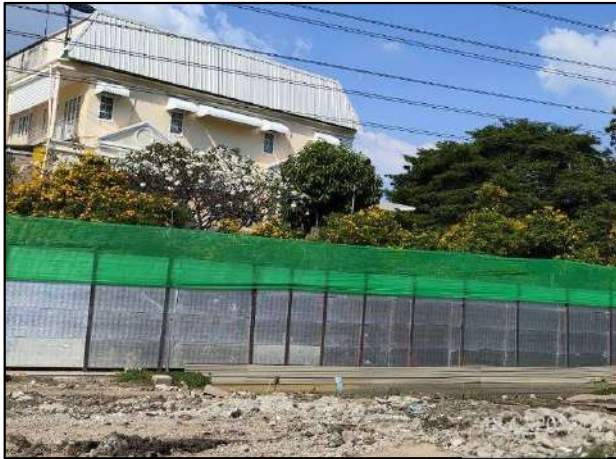
รูปที่ 2-5 ติดตั้งแผงพลาสติก/ผ้าใบเพิ่มเติม เพื่อป้องกันการฟุ้งกระจายของฝุ่นละอองในบริเวณพื้นที่ก่อสร้าง
