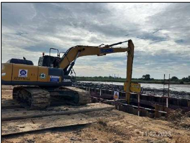
ค) กันเขตพื้นที่ก่อสร้าง พร้อมติดตั้งป้ายสัญญาณแสดงบริเวณที่ทำการขุดเปิดพื้นที่
