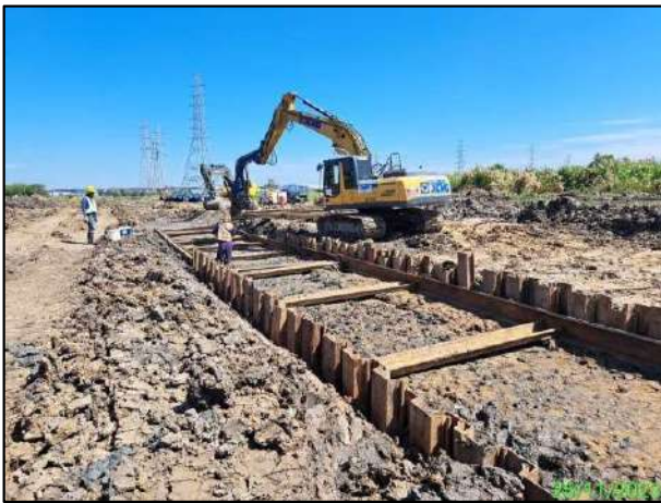
จ) การติดตั้ง Sheet Pile ป้องกันดินถล่ม
