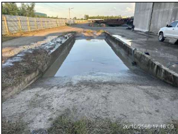
รูปที่ 2-8 การจัดทำพื้นที่ล้างล้อทำความสะอาดเศษดินและเศษโคลนที่ติดกับล้อรถ ก่อนออกจากพื้นที่เก็บกองท่อ (Stock Yard)
