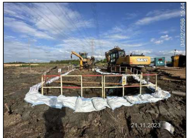
รูปที่ 2-15 การวางถุงทรายหรือจัดทำคันดินกันรอบพื้นที่บ่อรับ- บ่อส่ง
