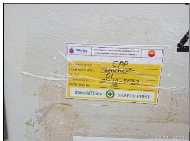
รูปที่ 2-9 การติดแถบสีสติ๊กเกอร์แสดงการตรวจสอบของเครื่องจักรและอุปกรณ์ต่างๆ
