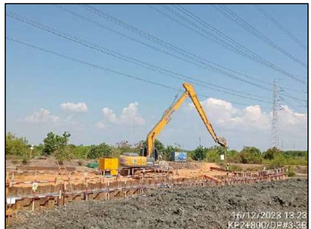
ค) กันเขตพื้นที่ก่อสร้าง พร้อมติดตั้งป้ายสัญญาณแสดงบริเวณที่ทำการขุดเปิดพื้นที่
