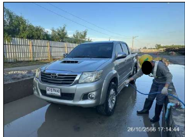
รูปที่ 2-8 การจัดทำพื้นที่ล้างล้อทำความสะอาดเศษดินและเศษโคลนที่ติดกับล้อรถ ก่อนออกจากพื้นที่เก็บกองท่อ (Stock Yard)
